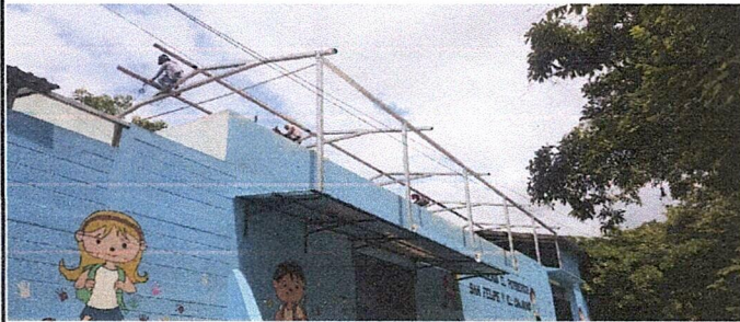
Foto 3: Seguimiento al mejoramiento de la estructura de techo.
