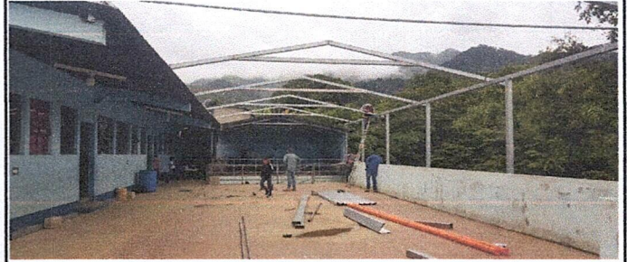
Foto 2: Colocación de Estructura metálica para el mejoramiento del techo.
